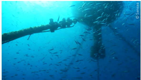
! Démonstrateur pour les ancrages vue de la surface et vue de la partie sous-marine
