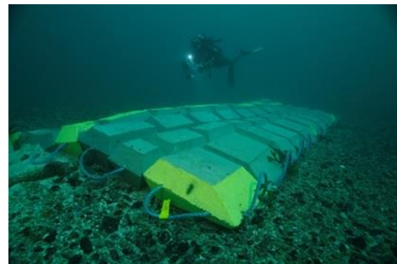
Fig. 6 : Mattress protection (© Olivier Dugornay, Ifremer)
