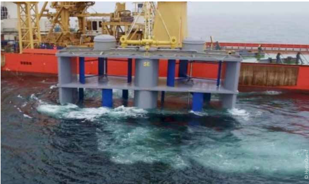
Fig. 48 : Mise à l'eau de l'hydrolienne HydroQuest Ocean sur le site de Paimpol-Bréhat.
