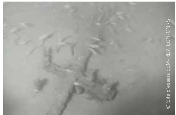
Fig 32 : Image prise à l'aide d'un ROV d'une équerre de fixation utilisée pour la portion posée de l'ombilical de Floatgen, autour de laquelle se concentre un banc de tacauds.
