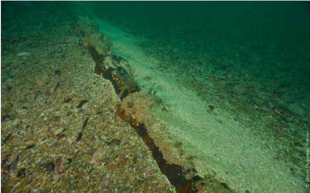
Fig. 2 : Accumulation de sable coquillier le long du câble de raccordement du site d'essais de Paimpol-Bréhat.
