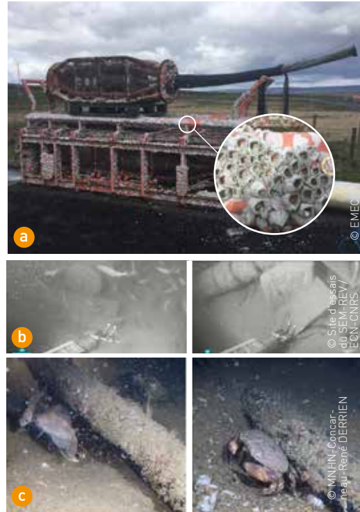
Fig. 55 : Colonisation benthique sur différents types de câbles et structures associées.
