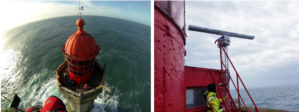
A gauche : Phare de la Jument vu du ciel (© Mickael Accensi, IFREMER) - A droite : Mise en place du radar sur la galerie du phare (© France Energies Marines)
